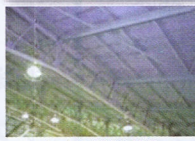
避難所指定の県立学校体育館に天井材落下防止ネットを設置【完了数 0校→57校】
