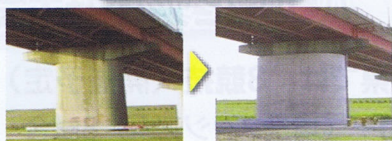
緊急輸送道路の橋りょう耐震補強を前倒し【9橋で進捗を前倒し】
